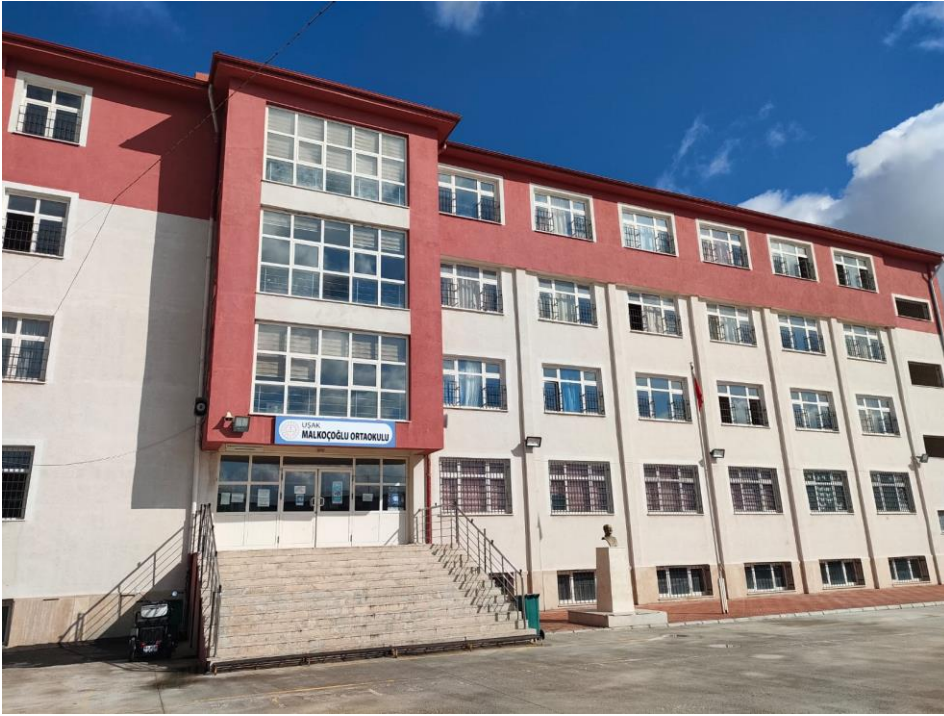
Şekil 3:Malkoçoğlu Ortaokulu Binası
